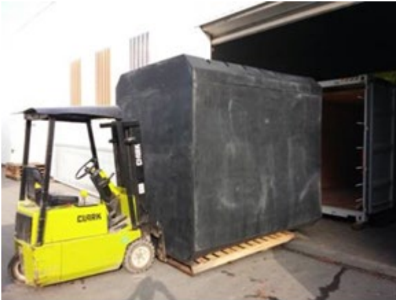
Behälter-Installation in einen Seecontainer
