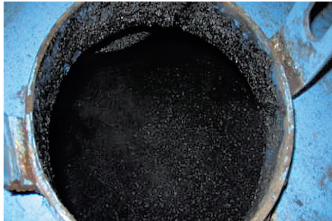
Verschlammter Kiesfilter
