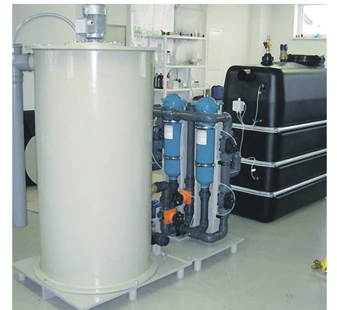
ClearFox® TBZ mit Brauchwassertank bis 40m³/h
