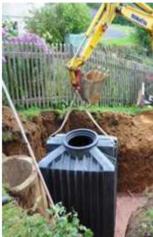
Setzen der Anlage
