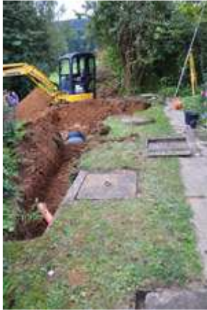
Einbau der Anlage mit Hilfe eines Mini Baggers
