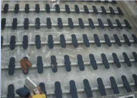
Belüftungssystem für Denitrifikation,
